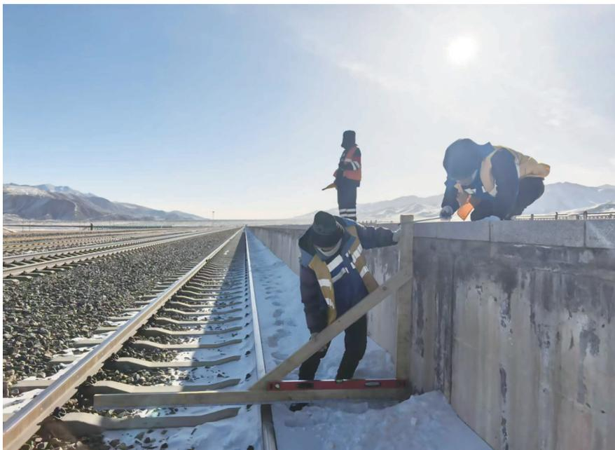
五道梁桥隧车间职工正在测量站台限界。
