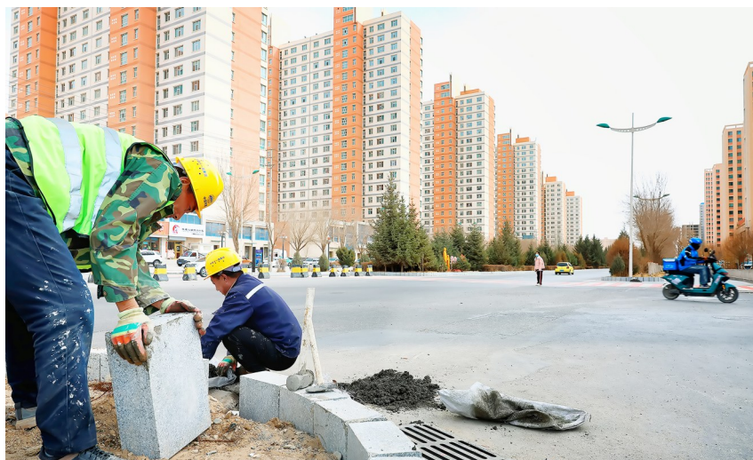
图为施工人员正在铺设新的路缘石。
