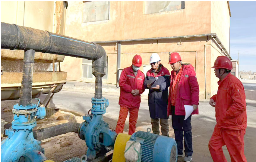
工作人员对复工复产企业进行全面检查，现场提出隐患整改意见并要求限期整改到位。 通讯员 马晓燕 摄
