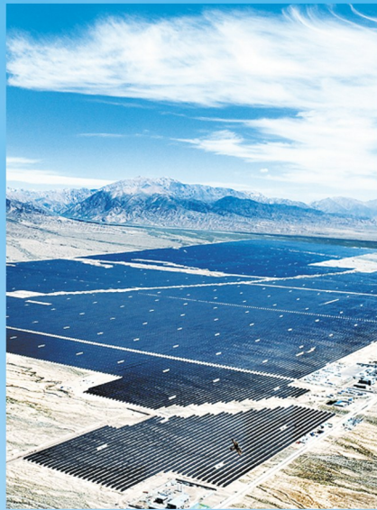
华电青海公司德令哈100万千瓦光氢储项目。 华电青海公司供图
