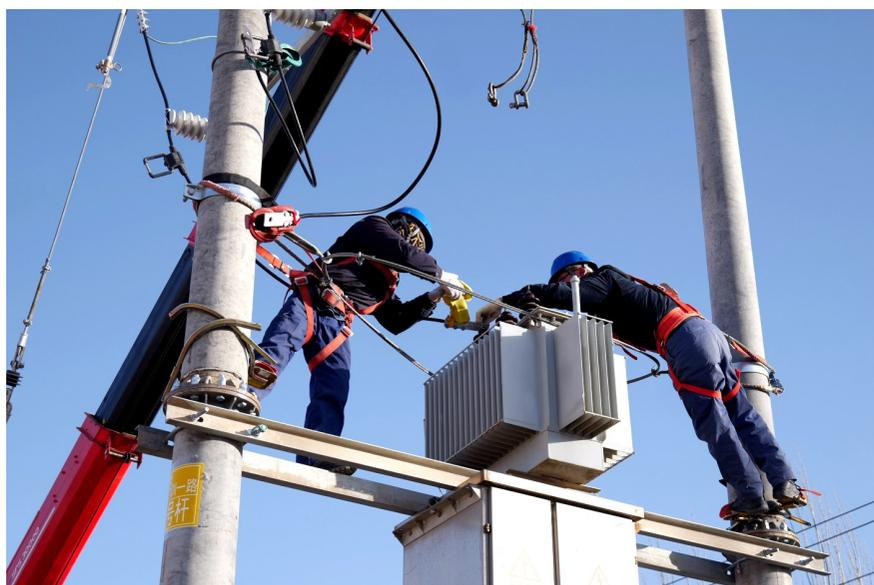
配网安装第一阶段。在配网抢修现场，目前导线安装已完成，抢修人员正在指挥吊车吊装柱上变压器的工作……”随着解说员的解说，大屏上出现相应的画面。抢修人员对变压器进行专业检测，
