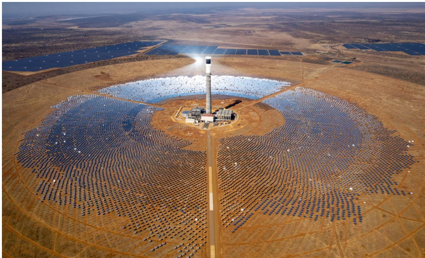
这是8月20日在南非北开普省拍摄的南非红石100兆瓦塔式熔盐光热电站项目（无人机照片）。 新华社记者 张誉东 摄
