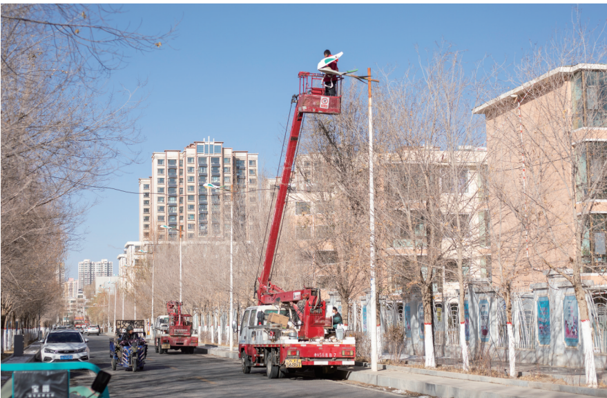
近日，市政设施管理处组织人员对市区各主、次干道的损坏路灯进行更换。近年来，我市不断加强路灯设施维护管理，着力提升夜间照明度，服务保障城市夜环境，城市对外形象不断提升。 记者 马俊杰 摄
