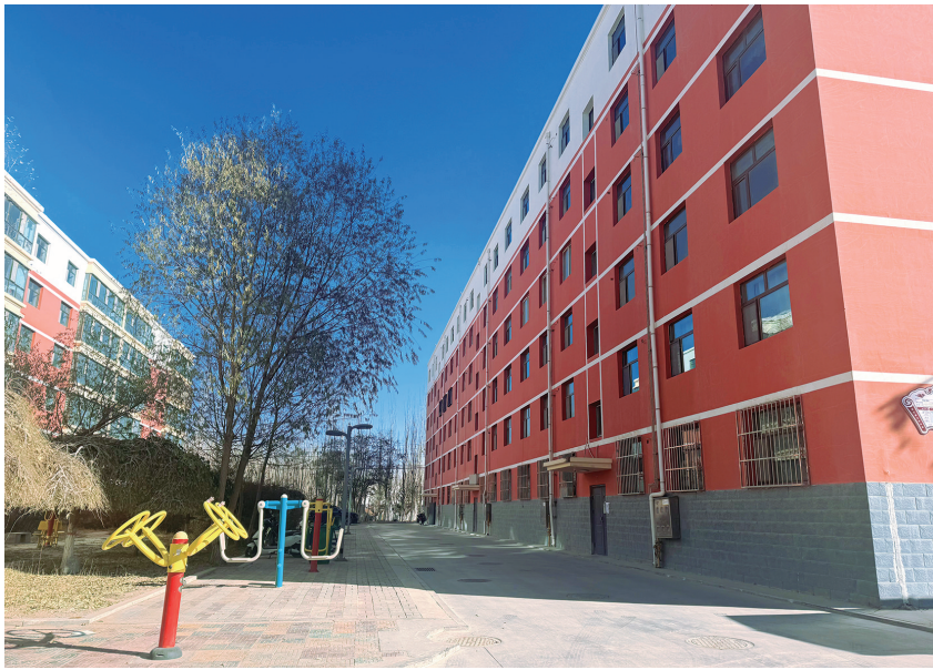
图为改造完成的泰康小区。
