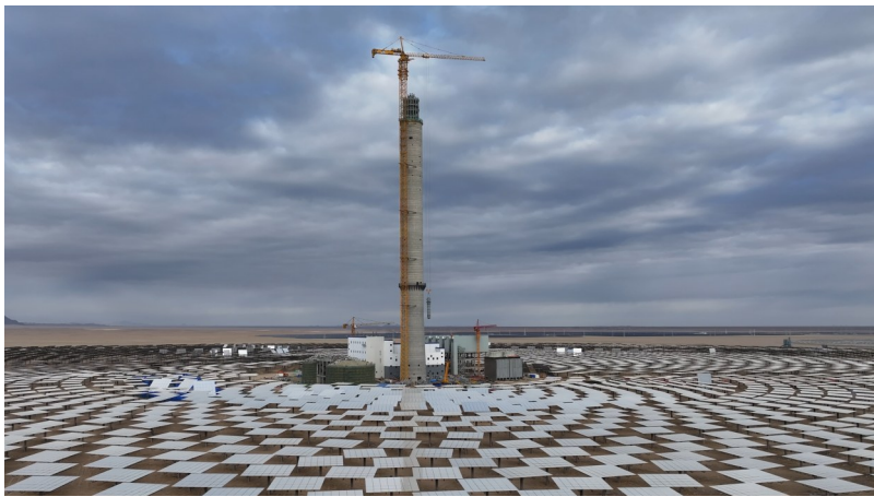
近日,三峡能源格尔木100兆瓦光热项目厂用系统受电一次成功,标志着工程建设正式进入分系统调试阶段。 通讯员 胡吉容 摄
