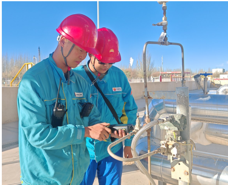
工人正在检查天然气管道，确保设施设备运行正常和供气安全。 记者 马彩萍 摄
