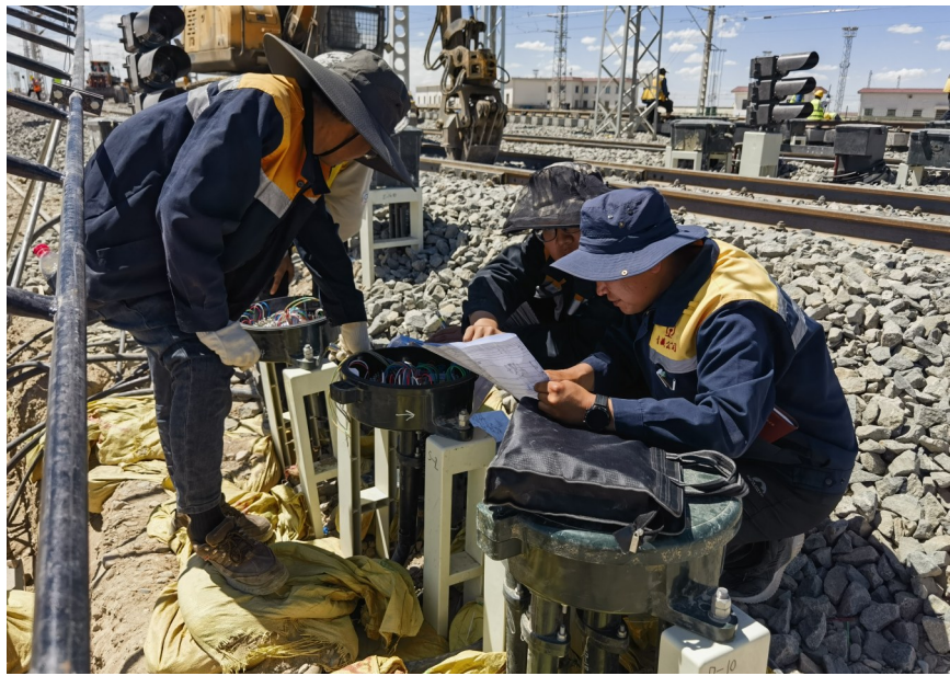
阿生军正在给施工小组讲解设备原理。
