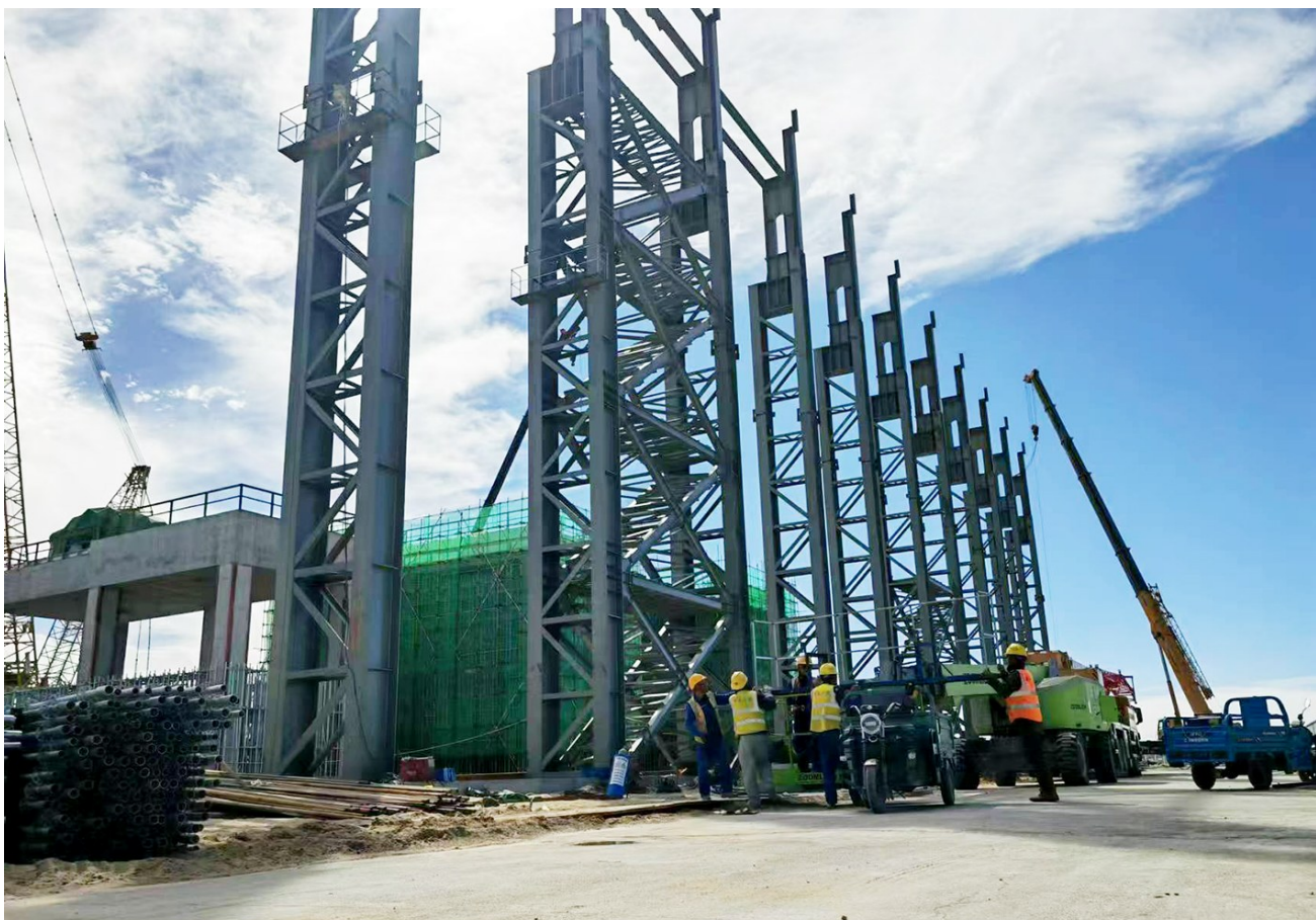
青海液态空气储能示范项目格尔木施工现场。
