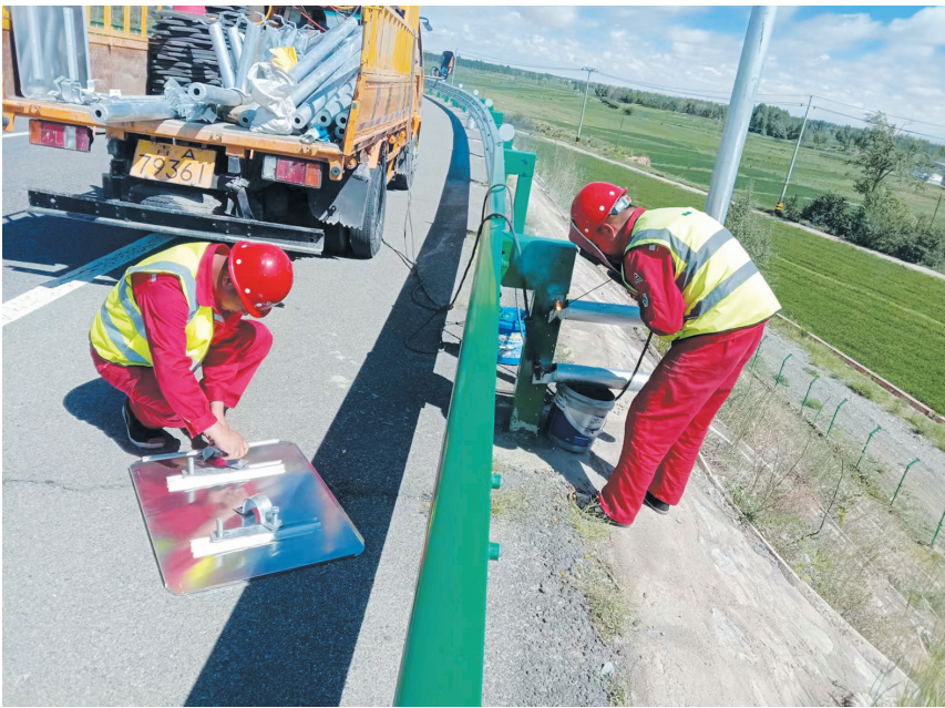
工作人员正在修复损毁的交通安全设施。
