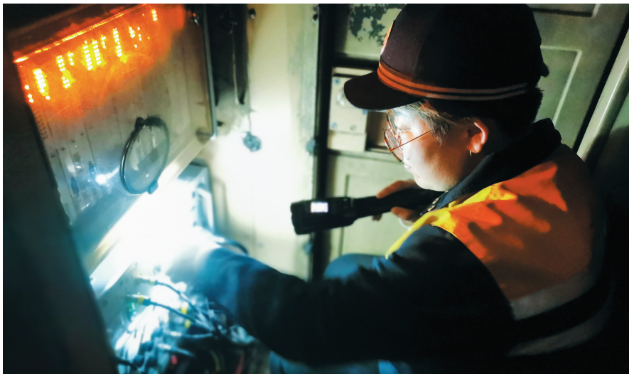
通信工正在机车电器间检查设备。
