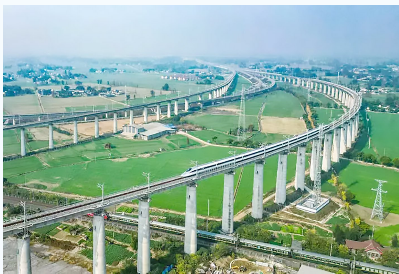
11月28日,成都市青白江区境内行驶在川青铁路上的列车(上)与行驶在宝成铁路线上的列车(下)交会。当日,川青铁路四川首段青白江东至镇江关段贯通运营。 新华社记者 王曦 摄
