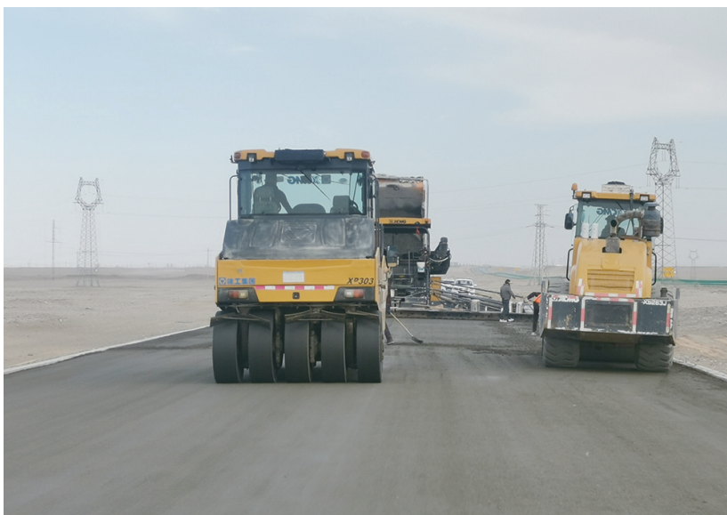
109国道宗格公路现场摊铺使用了全路面宽度的专业化大型摊铺机,严格控制施工工艺,减少水稳层横纵向接缝,以保证基层整体性。 通讯员 刘益航
