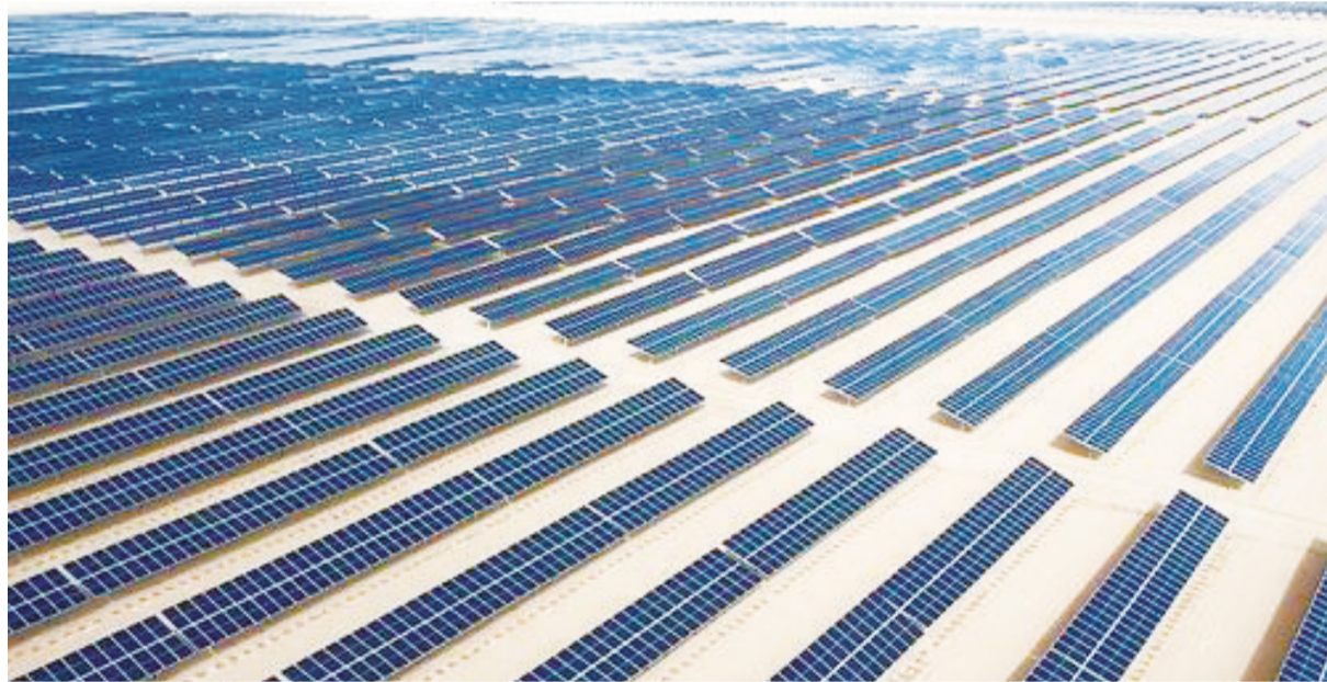
三峡集团光伏项目一角。 记者 仁增加措 摄
