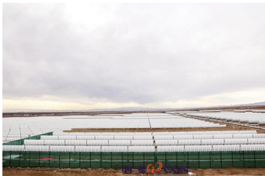
中广核项目现场。
