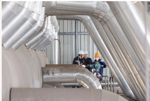
2月15日,检验人员对浙江省诸暨市一家能源公司的锅炉进行检验,确保生产安全。
