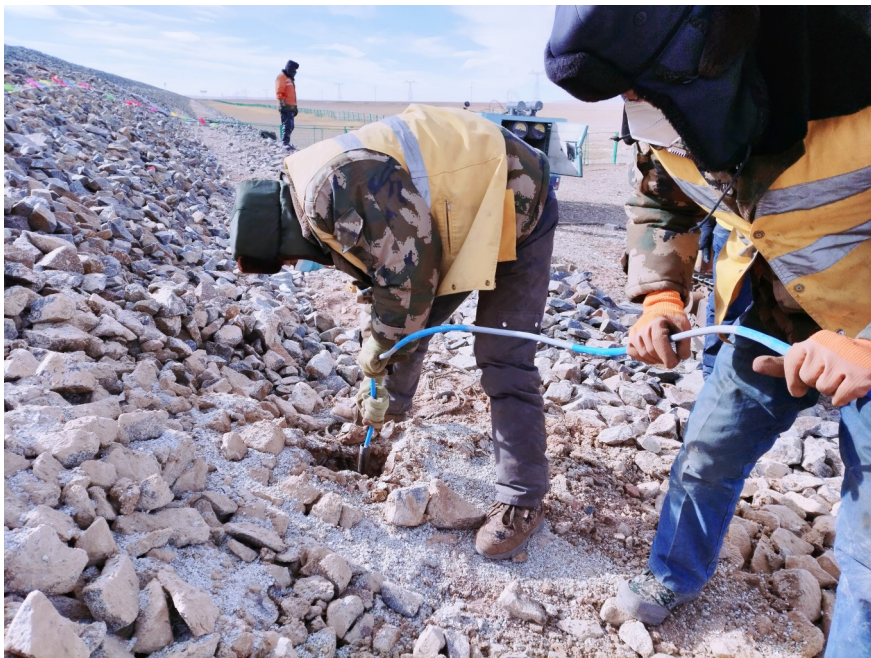
清水河桥隧车间的工作人员正在给高海拔路基量体温。
