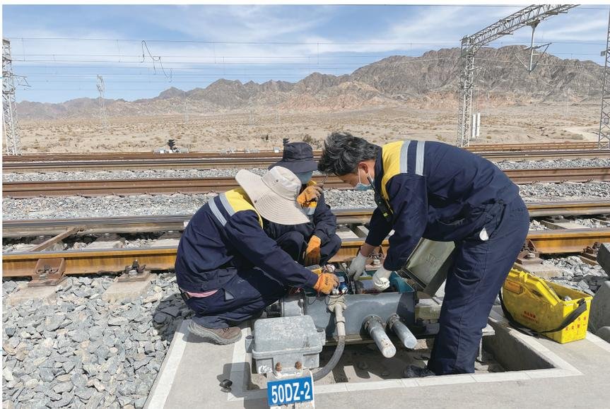
10月7日7时许，格尔木电务段格东信号车间锡铁山信号工区检修组对隧道内信号机和站内信号设备进行检修。经过5分钟左右的调试，信号机绿灯显示距离完全恢复正常。
