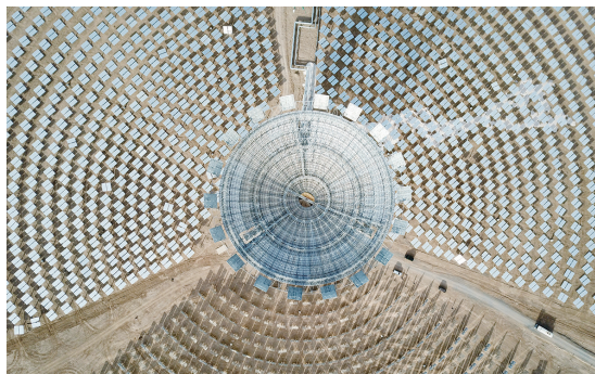
这是甘肃玉门鑫能50兆瓦熔盐塔式光热电站(2021年12月8日摄,无人机照片)。新华社记者 范培坤 摄
