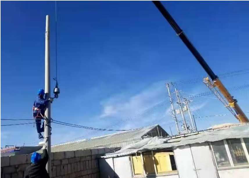
图为海西供电公司在河西供电所 10 千伏渔七路 65 号台区为客户移除电杆，消除安全隐患。
